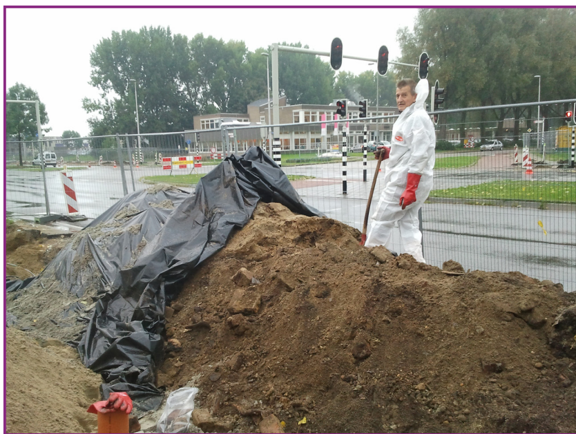
Afbeelding 19. Lammert van Pijkeren in saneringstenue op de vervuilde stort in het plangebied gezien vanuit het noordwesten.
